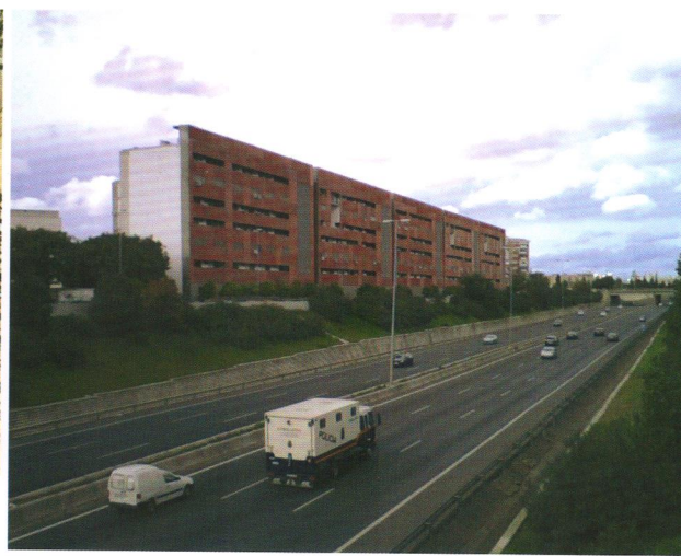
Fig 11. Edificio de viviendas en la SE-30, Sevilla. Fuensanta Nieto y Enrique Sobejano. Fotografía de Plácido González Martínez.
