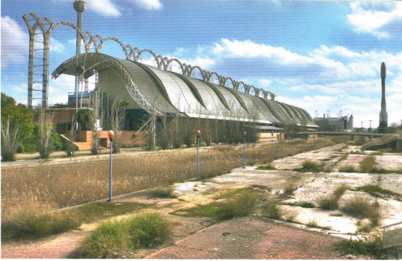
Pabellón del Futuro y el Canal de la Expo 92. Sevilla 2007. Fotografía de Scott Andress.
