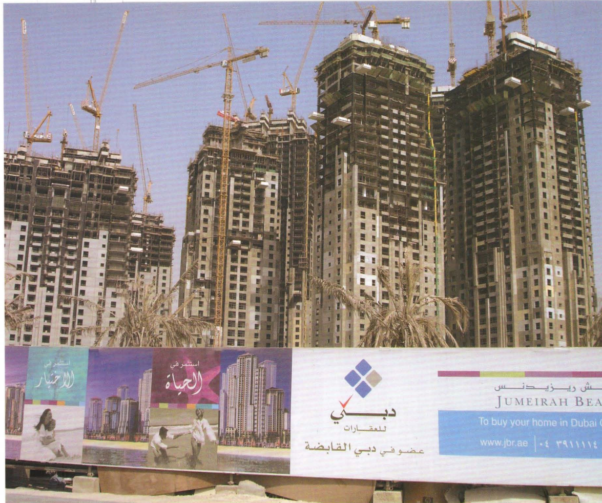
Jumeirah Beach Residences. Fotografía del autor, 2006.
