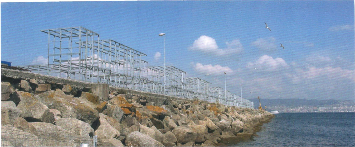
El edificio en construcción. Fotografía de los autores.
