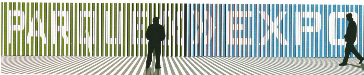
Cerramiento Cinético. Piezas extruidas de plástico reciclado.
