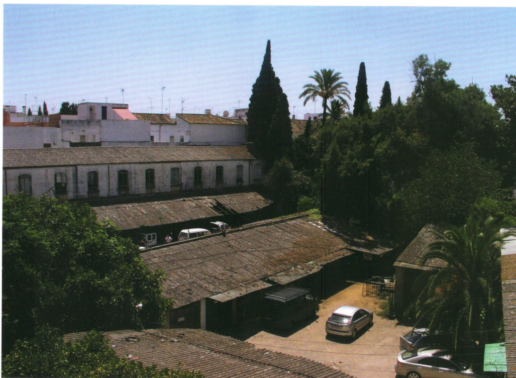
Vista del Corralón de Castellar. Fotografía de Jorge Yeregui.
