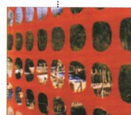
ENTORNO. MALLA DELIMITADORA DE OBRA
