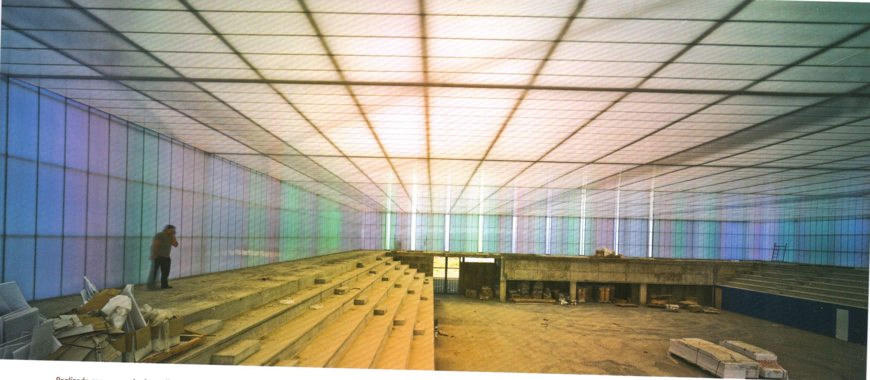
Realizada con economía de medios, esta estructura, desnuda de piel y huesos, crea en su interior una atmósfera de luz amortiguada y uniforme.
